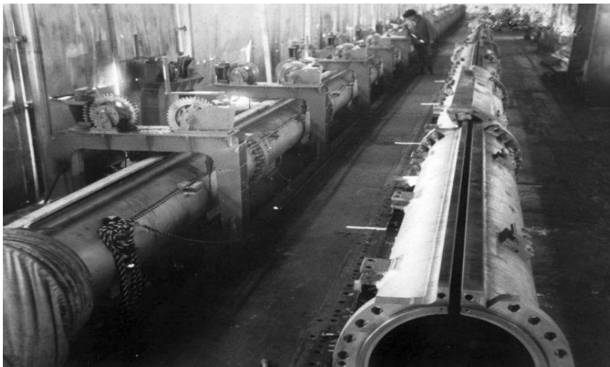
Рис. 5-3. Монтаж катапульты для недостроенного вследствие распада СССР тяжёлого авианесущего крейсера «Ульяновск» (Пр. 1143.7).
